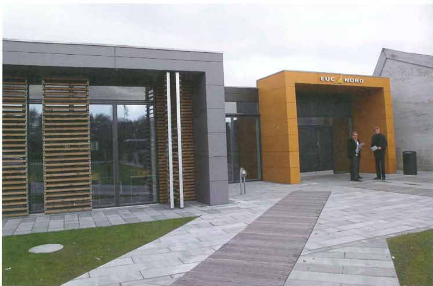
En tillbyggnad på 1.200 kvm till skolan EUC Nord i danska Hjöring blir certifierad som passivhus. De rörliga solskydd i trä som syns på bilden kan manövreras av eleverna. En rationell och enkel konstruktion av tillbyggnaden gjorde att det inte blev någon merkostnad i förhållande till traditionellt byggande. Arkitekt: Bjerg arkitektur a/s.
