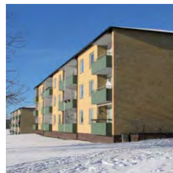
Brogården före renoveringen
